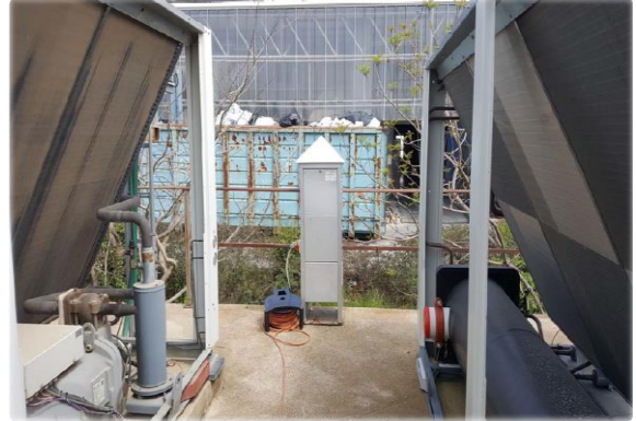
נק' דיגום במפעל תפן פלסט - צמוד למפעל וולקן
